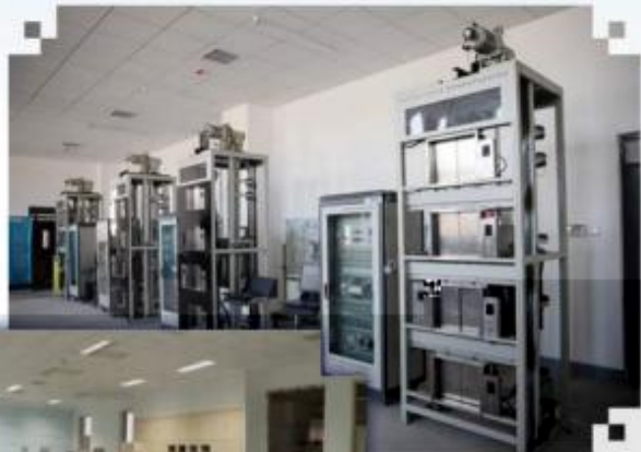
智能电梯安装调试 维护训练场所
